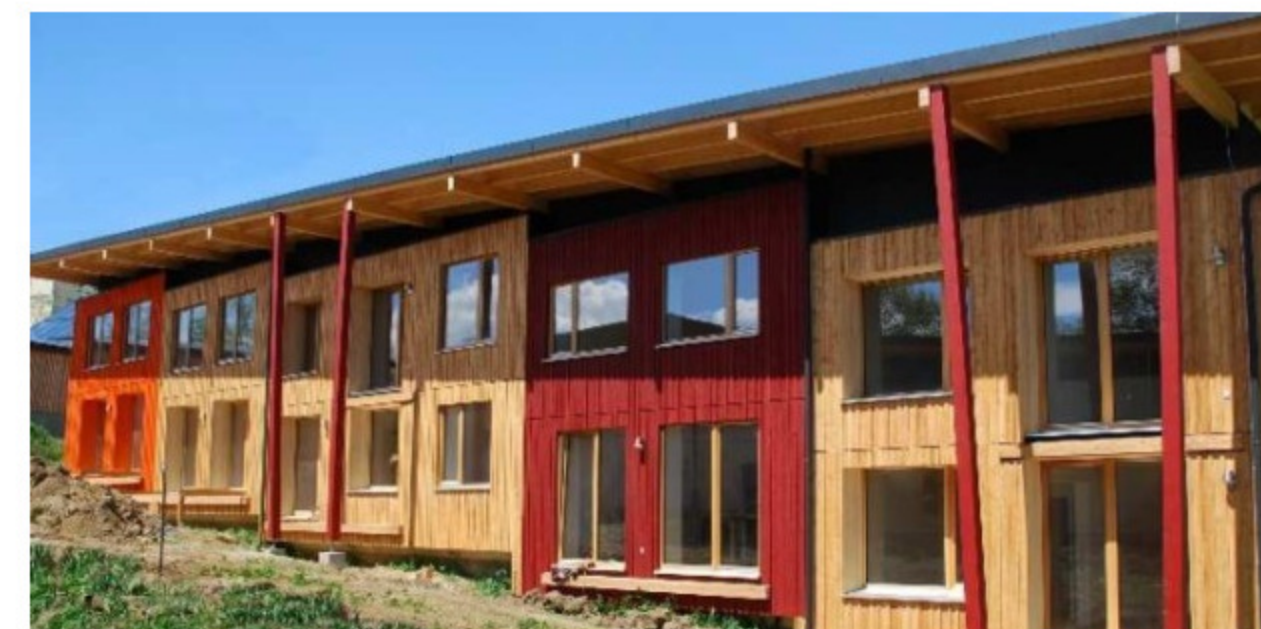
Mehrparteienhaus kurz vor Fertigstellung © GrAT: Christina Böckl
