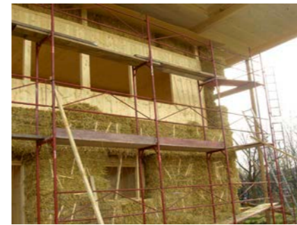
Eine wärmende Hülle aus 40 Zentimeter starken Strohbällen sorgt dafür, dass der Heizwärmebedarf des S-House nur etwa ein Zehntel des Heizwärmebedarfs eines konventionell errichteten Gebäudes beträgt.
